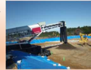
中間貯蔵施設 土壌貯蔵施設
