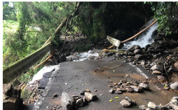
山間部の至る所で道路崩壊が。今回の豪雨は洪水被害ばかりではなく、山間部の地形や水流、川の流れさえ大きく変えた。
