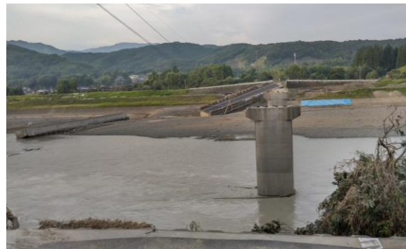
沖鶴橋流失。落ちるはずがないと誰もが思っていた橋でさえ、流されてしまった。
