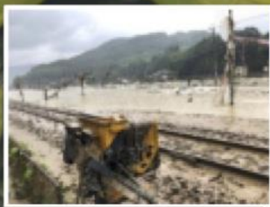
⑦地下地区被災状況
