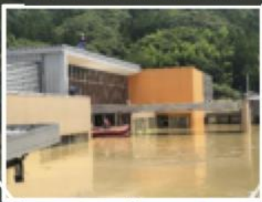
④千寿園浸水状況
