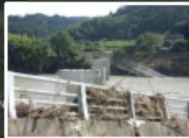
⑧沖鶴橋被災状況
