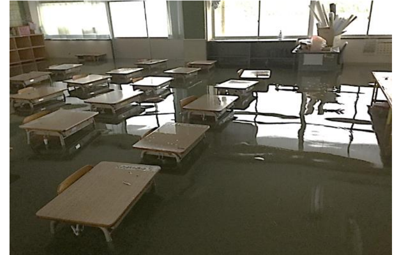
7月6日夕方 冠水し停電した1年生教室
